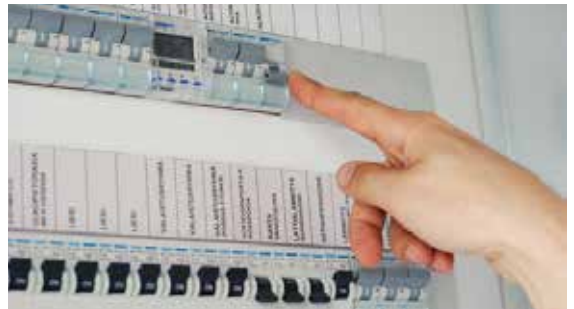
Kiinteästi asennettavan automaattisulakkeen asettaminen toimintakuntoon.
